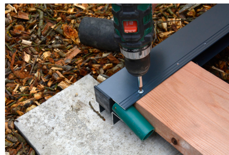
3. Fošnu doražte gumovou paličkou do profilu a přivrutujte. Pokračujte protilehlým rohem.
