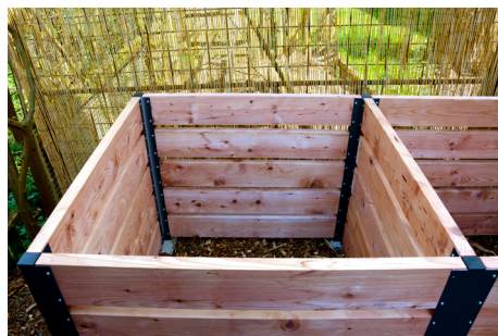
7. Zadní rohy a T-Spoje vrutujeme zevnitř. Přední zvenku kvůli budoucímu přístupu k snadnému přehazování.
