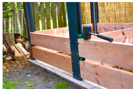
6. Distanční válečky používejte v každém patře a po přivrutování fošny je vyndávejte.
