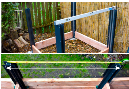
5. Zkontrolujte, zde je vše ve vodováze, a také, zda je rozstup profilů v horní části shodný s první vrstvou.
