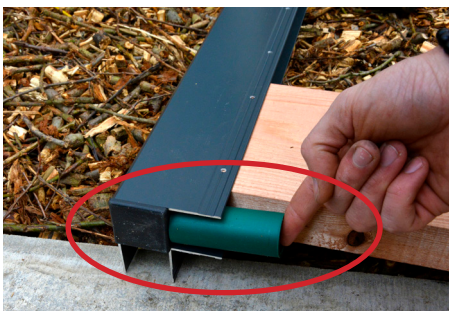
2. Začínáme od spodu - nasadíme záslepky a použijeme distanční váleček - profil je předvrtaný tak, aby dole vznikla mezera pro přístup vzduchu
